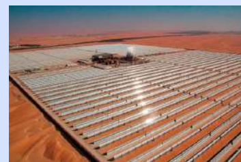
Shams 1, la mayor planta solar de Oriente Medio. EAU.
