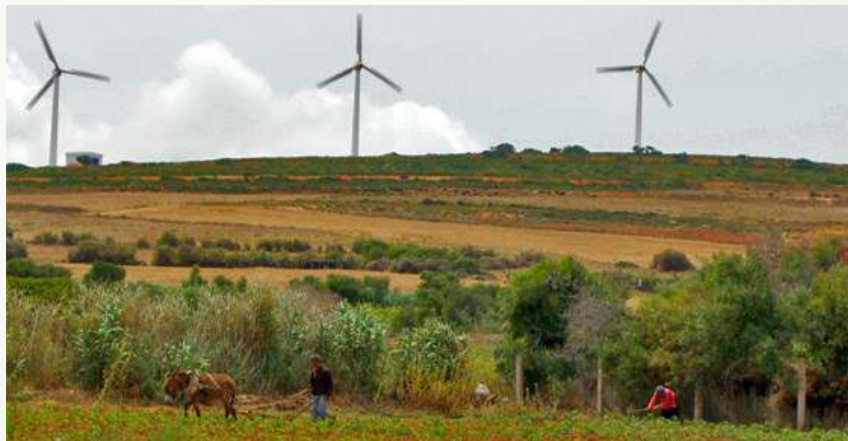
Aerogeneradores en Túnez. Fuente: www.ewind.com
