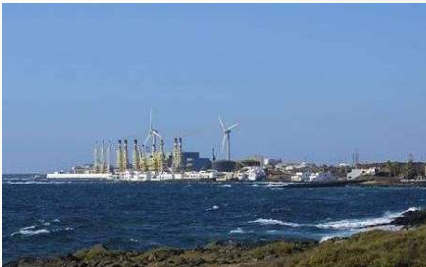
Planta desalinización en Jordania. Fuente: Mena FN
