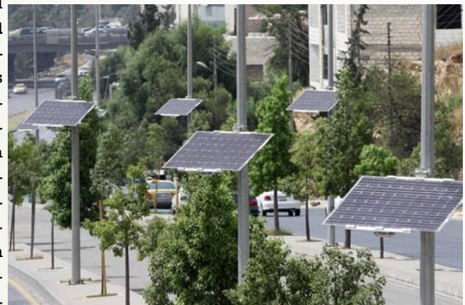
Paneles solares colocados en una calle de Amán, Jordania. Fuente: The Jordan Times
